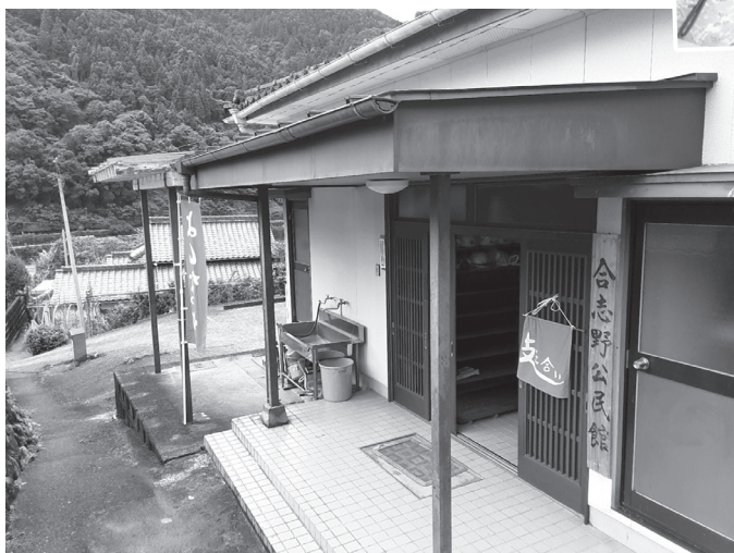
被害をまぬがれた合志野公民館
