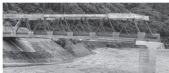
坂本橋も工事が進んでいます
