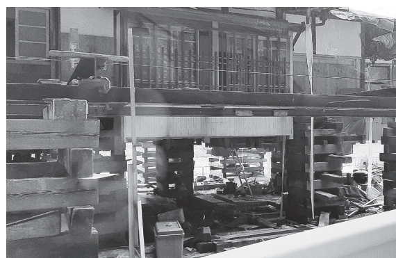
宅地かさ上げ工事中の坂本町の「鶴之湯旅館さん」
